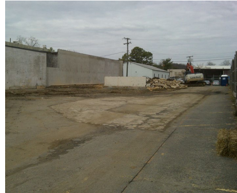
2700 S. Nelson St. Demolition
