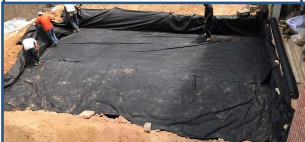
**Subsuelo excavado después de instalar la tela filtrante**
