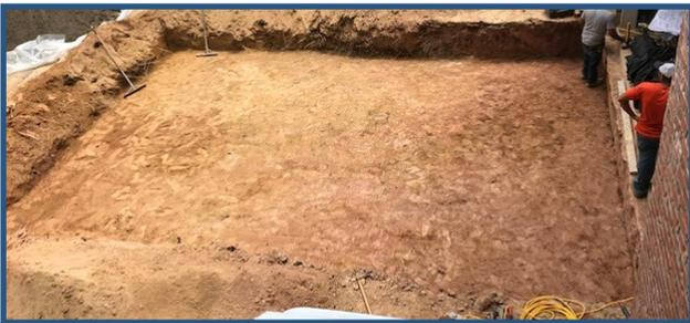
**Subsuelo excavado antes de instalar la tela filtrante**
