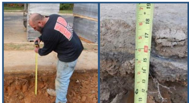
**Profundidad de corte en la plataforma del camino de entrada con un primer plano**
