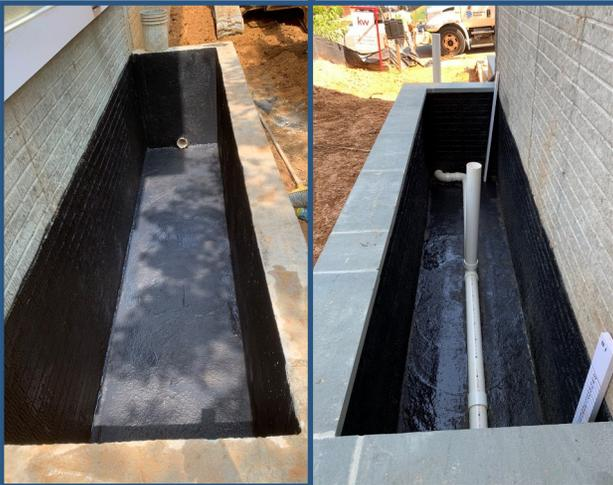
Foto de la impermeabilización aplicada y del tubo de desagüe perforado y el tubo de desagüe sólido
