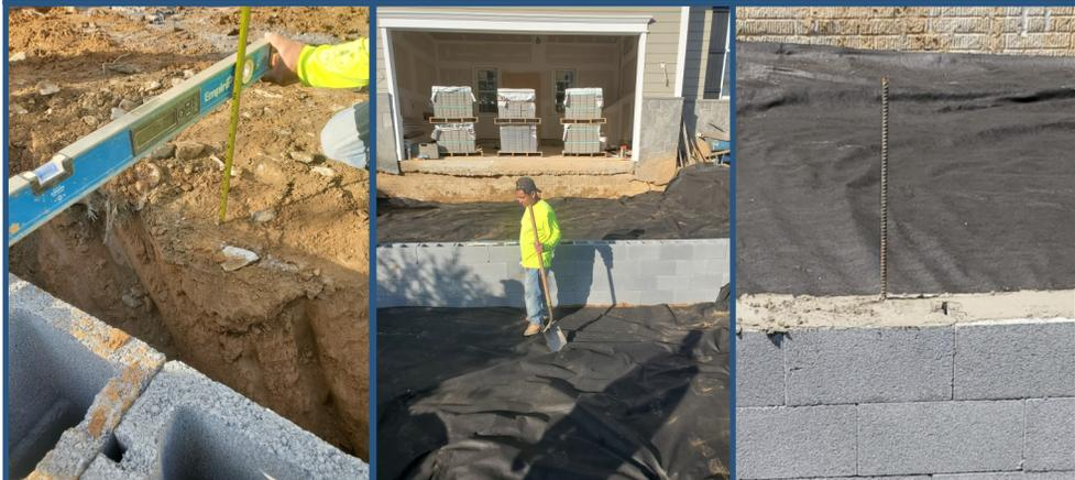
Foto clara de la altura de la barrera de flujo hasta el fondo de la celda superior
