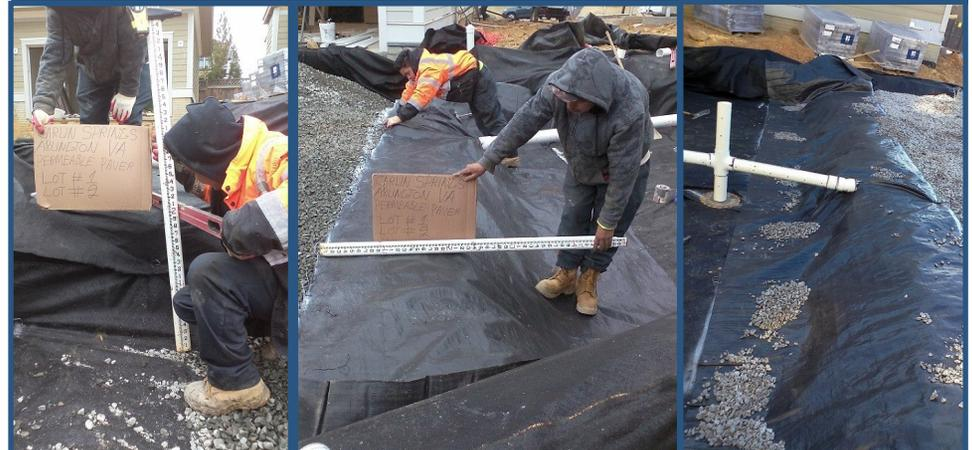
Fotos de mediciones claras de la altura de la barrera de flujo y del revestimiento impermeable que se extiende un mínimo de 12" hacia la siguiente celda
