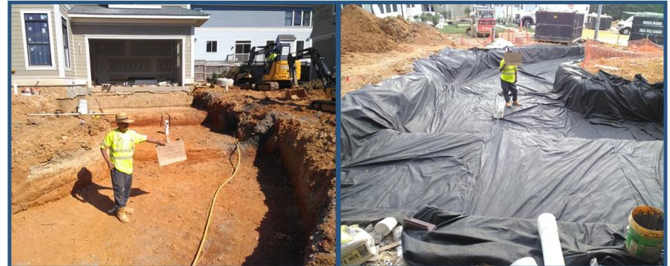
Fotos de todos los cortes de excavación donde se instalará la barrera de flujo
