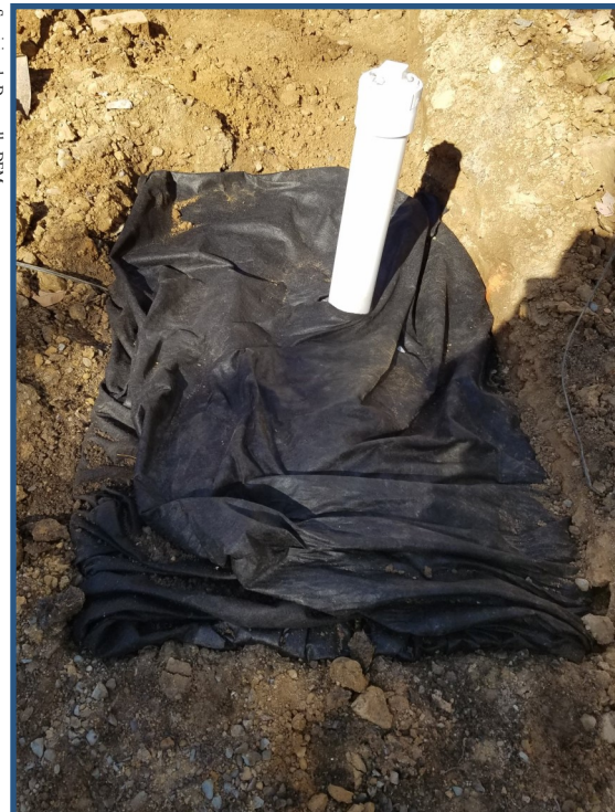
Grava #57 envuelta con tela filtrante, superponiendo la tela en la parte superior
