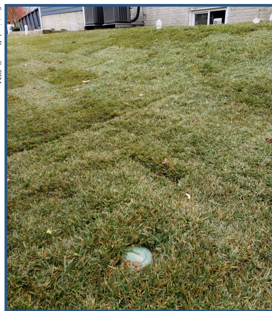
Césped y emisor emergente instalados
