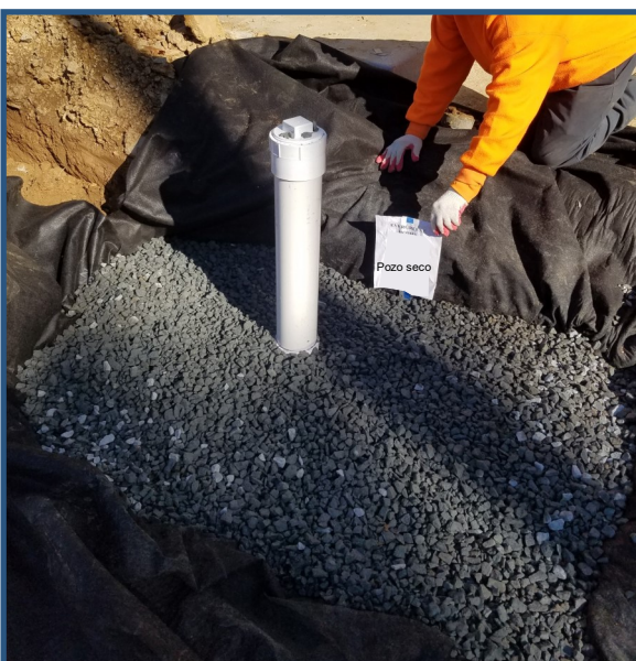
Foto que muestre la profundidad de la grava #57 instalada
