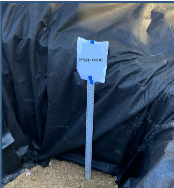
Foto clara de la profundidad. Si se instalan varios pozos secos, etiquetar las fotos durante la instalación
