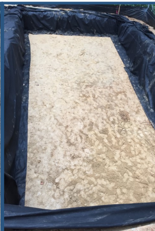
Foto de la tela filtrante solo en los lados
