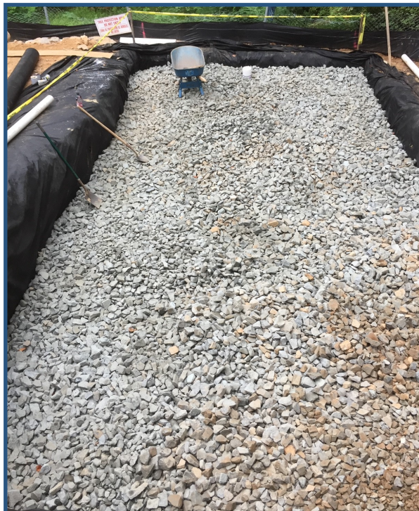
Foto de la profundidad de la piedra, según los planos aprobados
