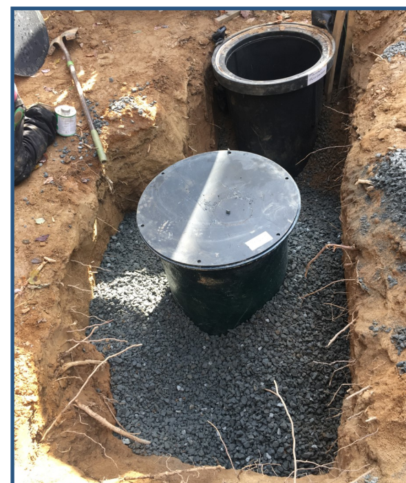
Foto de la instalación de las medidas de pretratamiento
