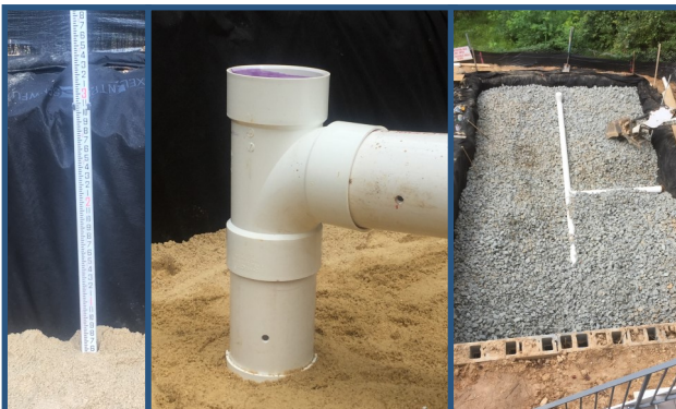
Instalación de la capa filtrante, los tubos de entrada y los tubos de salida
