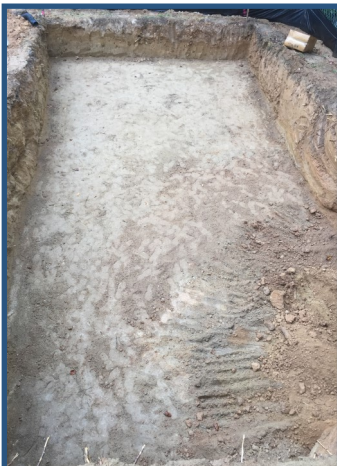
Foto de la zona excavada
